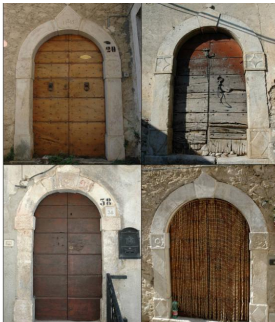
Figura 32 Tipologia 1 - Portale ad arco a tutto sesto in conci di pietra a punta decorato. Blocchi all'imposta dell'arco e alla base delle spalle in pietra decorata. Spalle in blocchi di pietra squadrate. Soglie in blocchi di pietra irregolarmente squadrate
