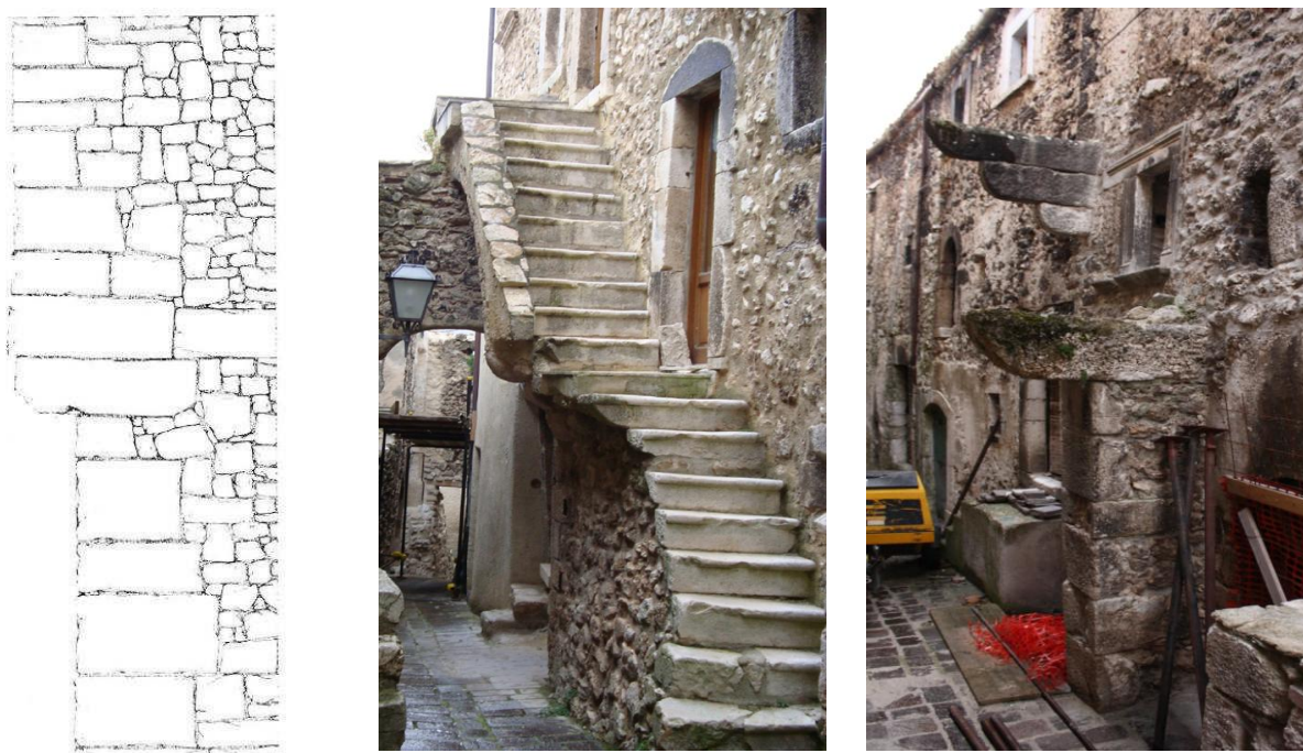
Figura 27 Tipico aggetto; la foto di una “casa a profferlo” di Navelli; a destra due aggetti per il sostegno di un profferlo a Castelvechio Calvisio.
