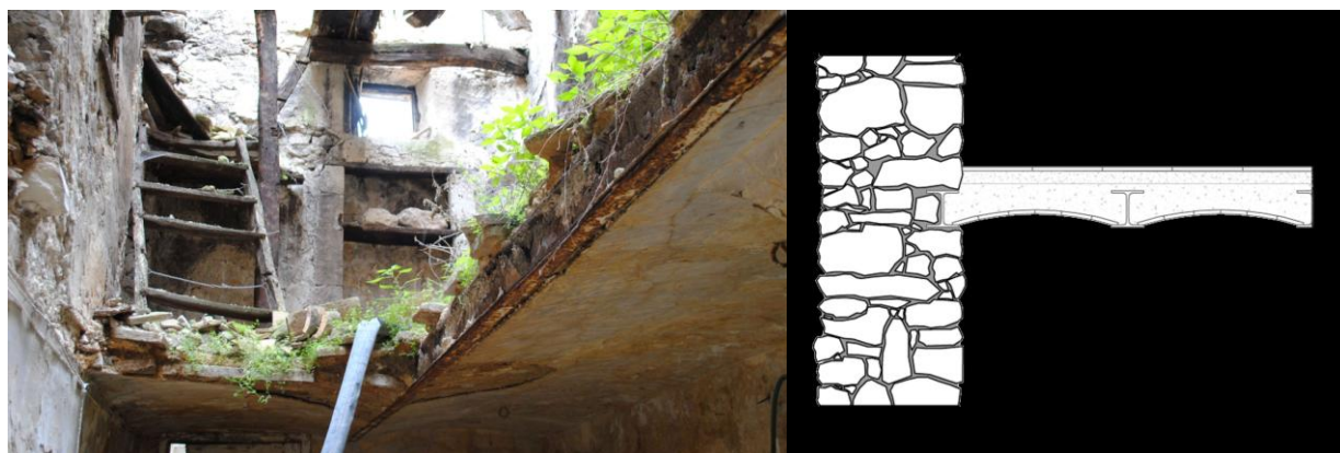
Figura 30 Esempi di solaio a putrelle e voltine ("volterrane")
