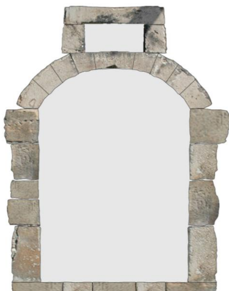
Figura 37 Portale con arco ribassato in pietra con concio centrale e sopraporta. Blocchi all’imposta dell’arco e alla base delle spalle in pietra grezza, spalle in blocchi di pietra irregolarmente squadrate. Soglia in blocchi di pietra irregolarmente squadrate.
