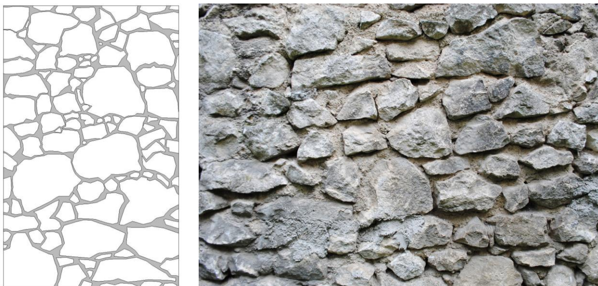
Figura 23 La successione di immagini mostra, da sinistra verso destra, una vista esterna del paramento murario e una foto riferita alla tipologia muraria in pietrame rilevata a Navelli, in un aggregato della zona intramuraria.
