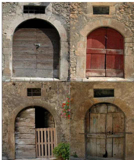
Figura 37 Portale con arco ribassato in pietra con concio centrale e sopraporta. Blocchi all’imposta dell’arco e alla base delle spalle in pietra grezza, spalle in blocchi di pietra irregolarmente squadrate. Soglia in blocchi di pietra irregolarmente squadrate.
