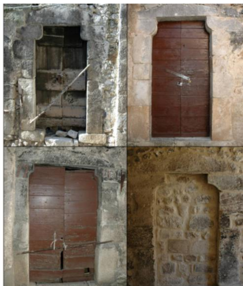
Figura 36 Portale con architrave monolitico triangolare in pietra grezza. Blocchi all’imposta dell’arco in pietra grezza sagomati concavi o convessi alla base delle spalle in pietra grezza, spalle in blocchi di pietra irregolarmente squadrate. Soglia in blocchi di pietra irregolarmente squadrate.
