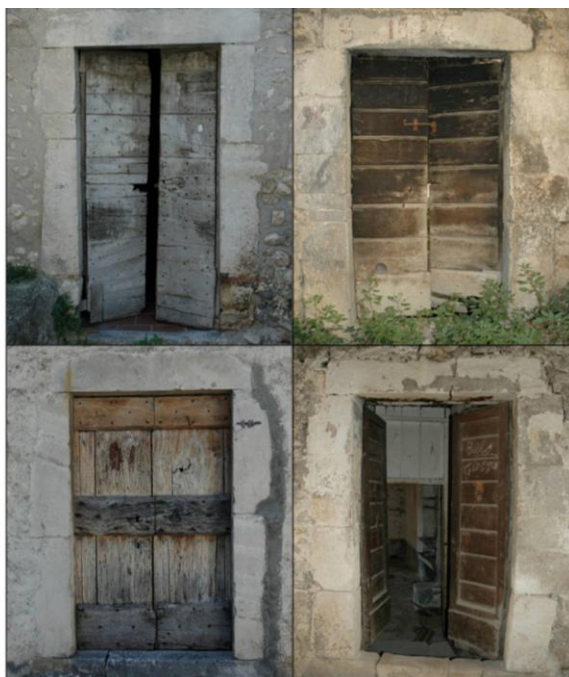
Figura 35 Portale con architrave monolitico. Blocchi all'imposta dell'arco e alla base delle spalle in pietra non decorata, spalle in blocchi di pietra irregolarmente squadrate. Soglia in blocchi di pietra irregolarmente squadrate.
