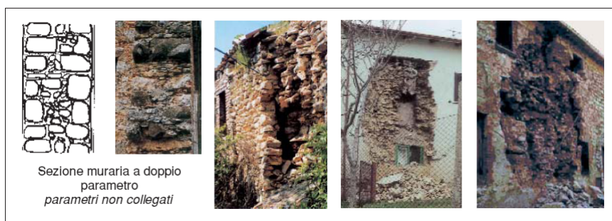
Fig 54 Sezione costituita da due paramenti non ammassati
