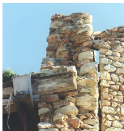
Fig 20 - Cellula di saturazione del tessuto edilizio (caso C, sopra) e conseguente assenza di ammorsamenti con i setti laterali (foto sotto)
